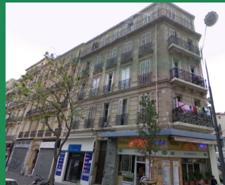
Bâtiment en face de la résidence
