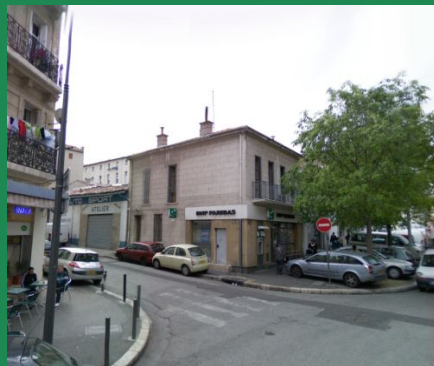
Emplacement résidence- Bâtiment à détruire
