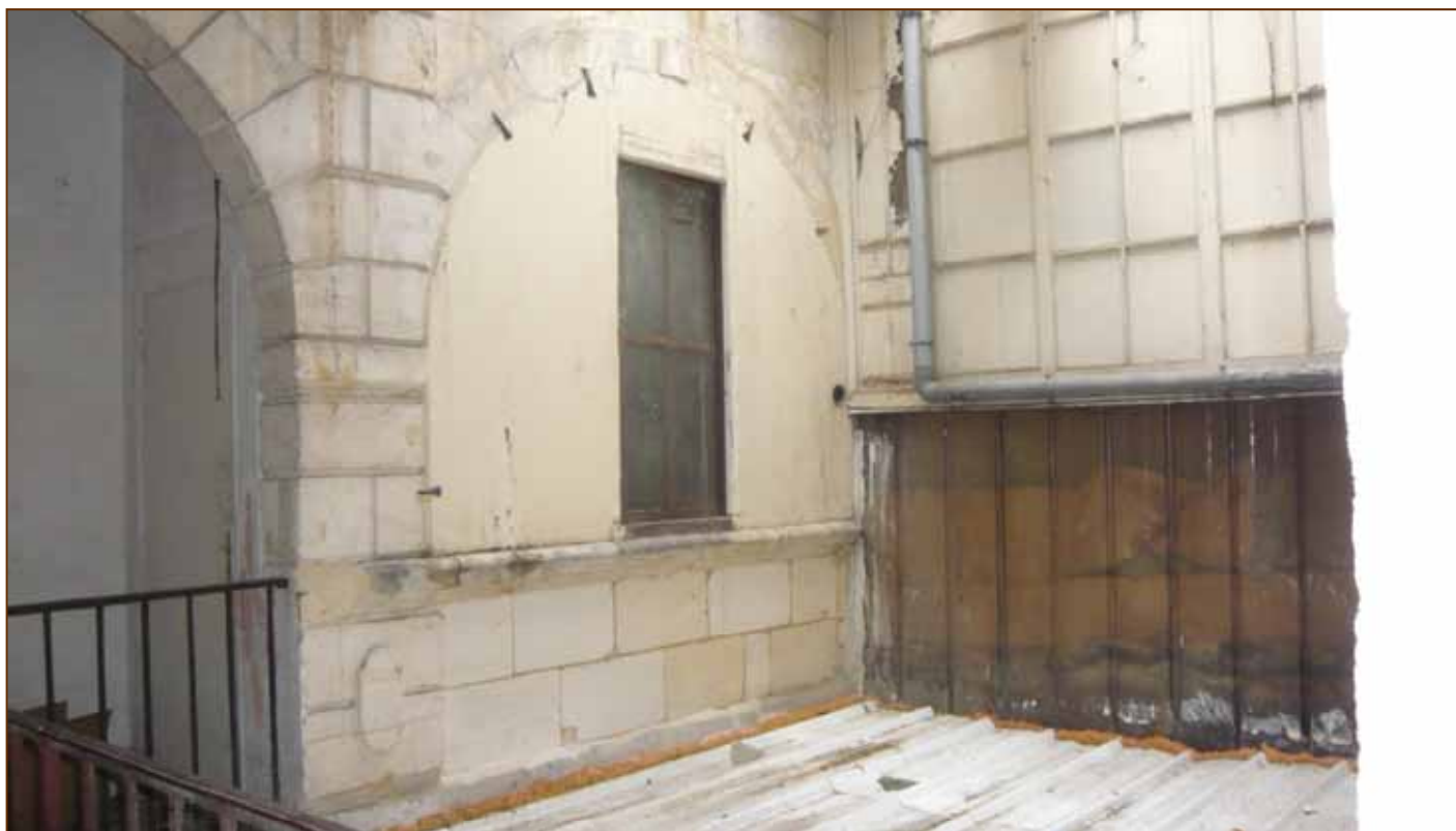
Puits de jour intérieur
