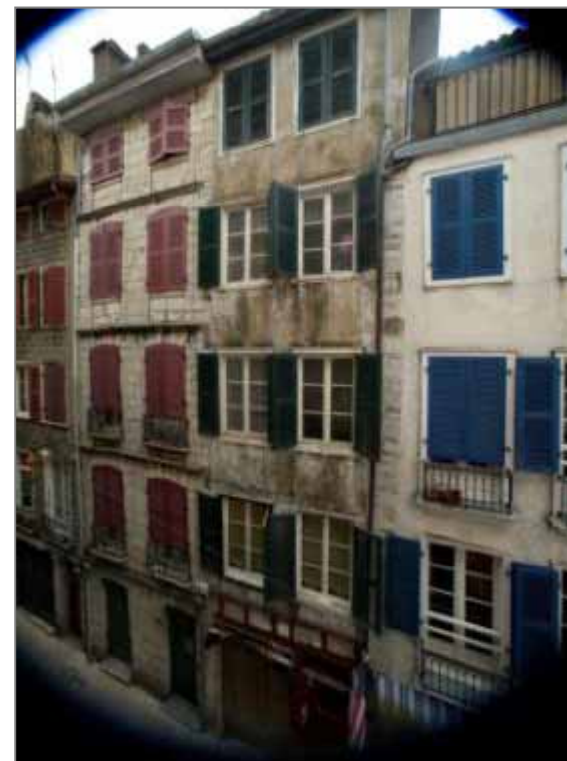
Façade arrière, sur la rue des Basques
